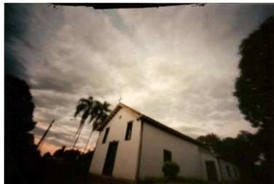
Igreja de São Sebastião, em Planaltina
